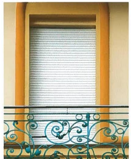
Roletový systém s boxem umístěným směrem do místo mezi oknem a horní stranou otvoru. Montáž tohoto plastového boxu je provedena ještě před samotným osazením okenního rámu. Roletový box je zateplen polystyrenovou vložkou a je opatřen revizním víkem.
