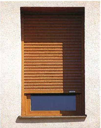
Ideální a nejlegantnější řešení na trhu určené zejména pro novostavby a rekonstruované objekty. Box rolety je zaomítlitelný a odizolovaný přímo ve zdi nad okenním otvorem a není tedy nikterak viditelný. Samozřejmostí je také integrace rolovací sítě přímo do roletového boxu.
