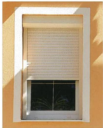
Roletové systémy určené zejména pro dodatečnou montáž. Nezasahují do stávajícího stavebního otvoru a zachovávají co nejvíce světlo v otvoru. Lamelový pancíř je navijen do hliníkového boxu umístěného na vnější straně. Samozřejmostí je také integrace rolovací sítě přímo do roletového boxu.
